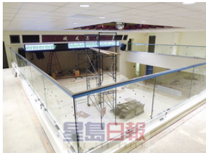
勝利堂當日仍開展翻新工程的情況，遠處為已重建的舞台。本報資料圖片
